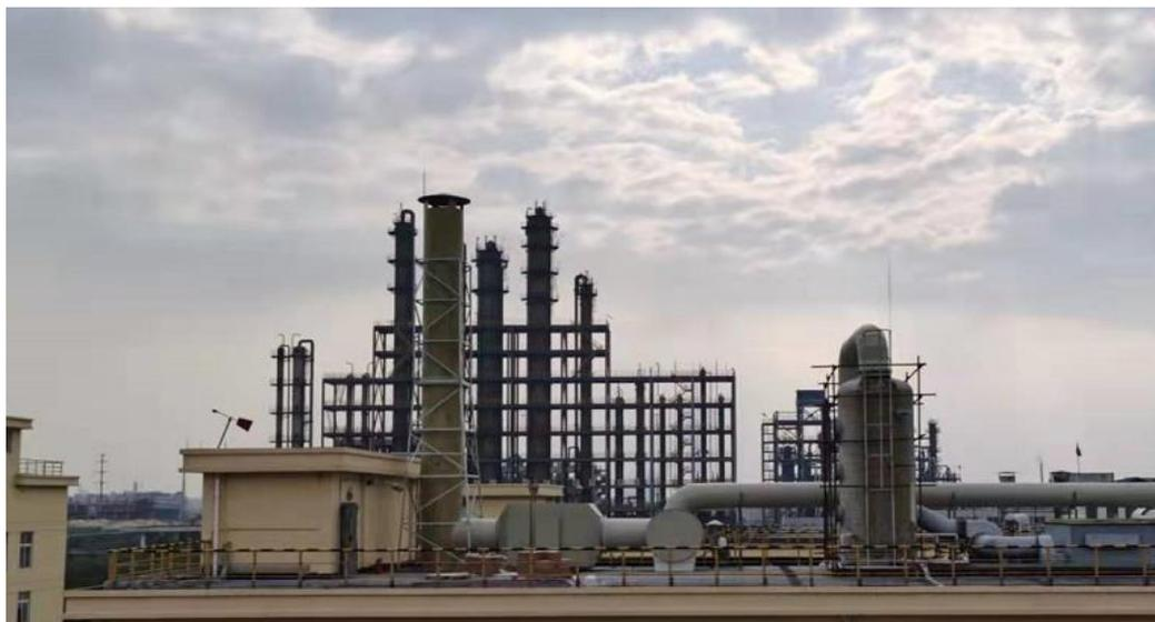
六车间精馏+储罐呼吸废气二级活性炭+碱喷淋处理设施及排气筒 DA005
