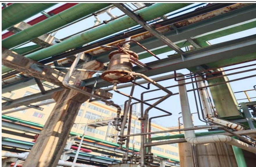
六车间精馏+储罐呼吸废气二级冷凝处理设施
